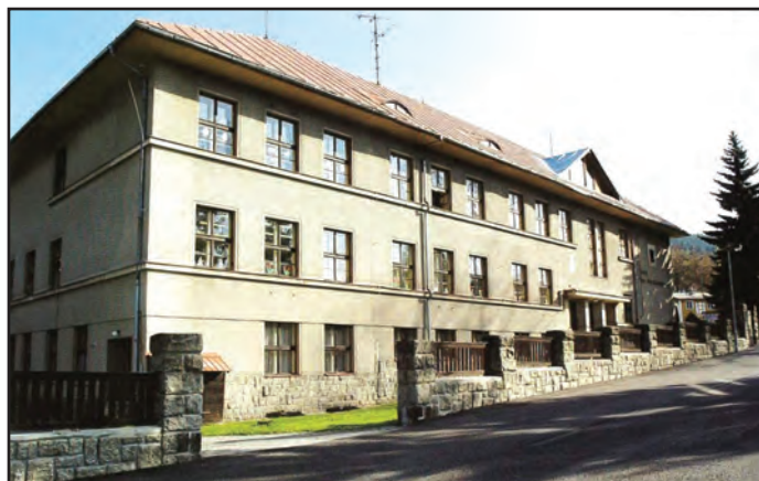
Budova školy před zateplením.
