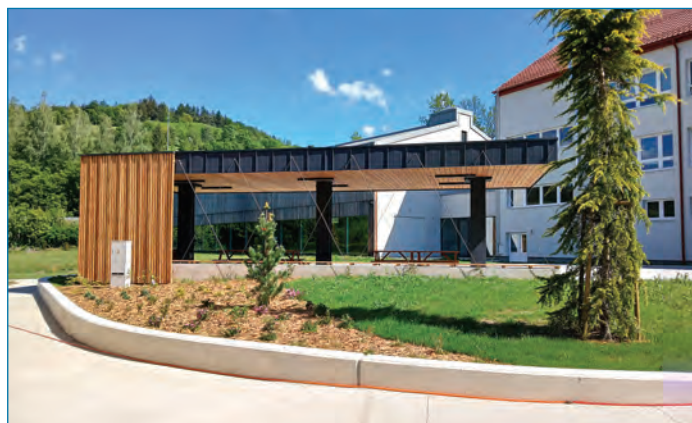
Venkovní učebna školního dvora.
