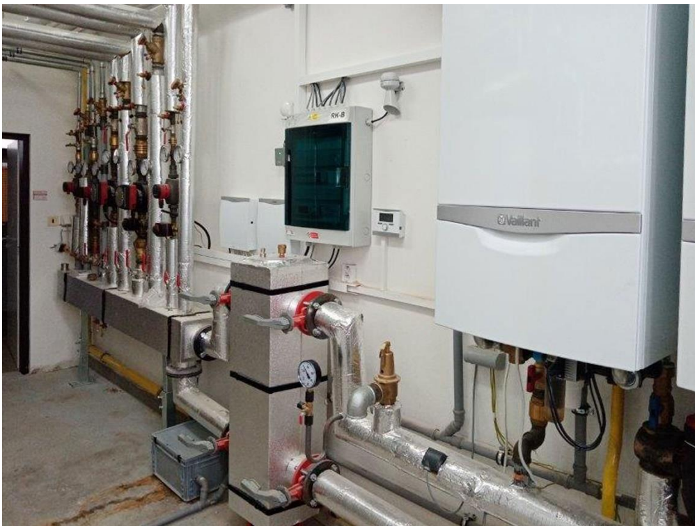
Nová kotelna - objekt B
