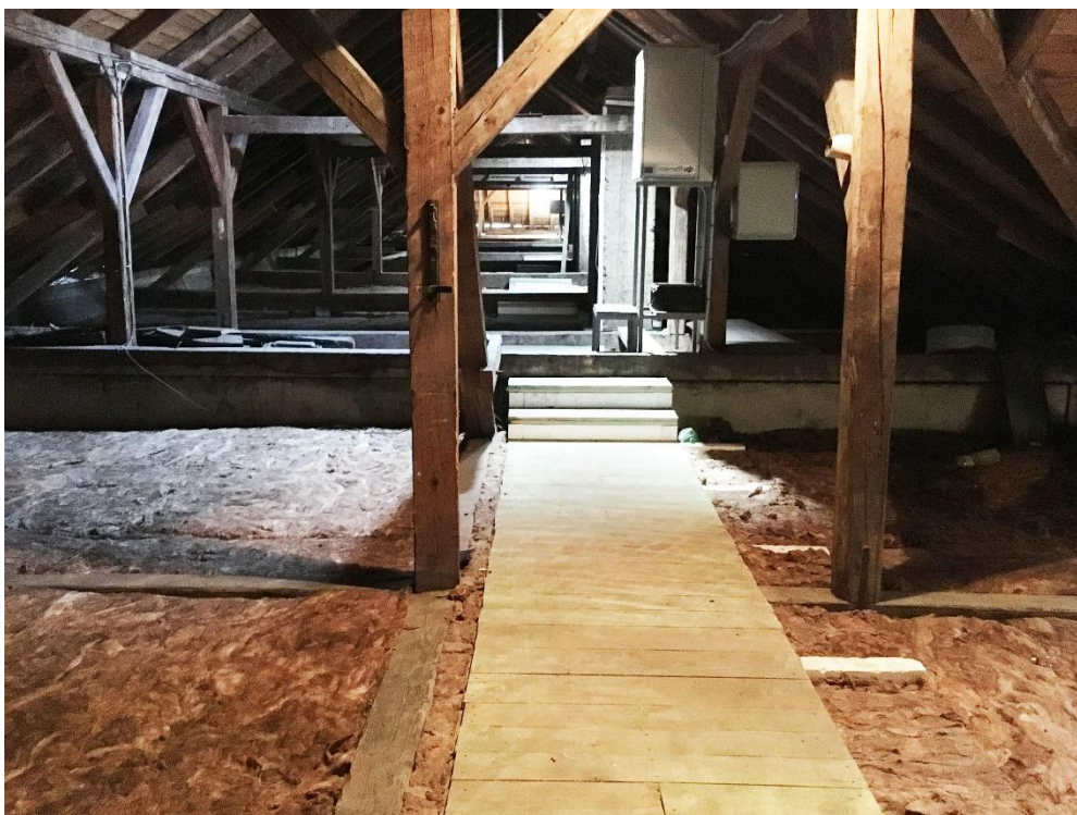
Po realizaci - zateplení stropů půdy objektu A
