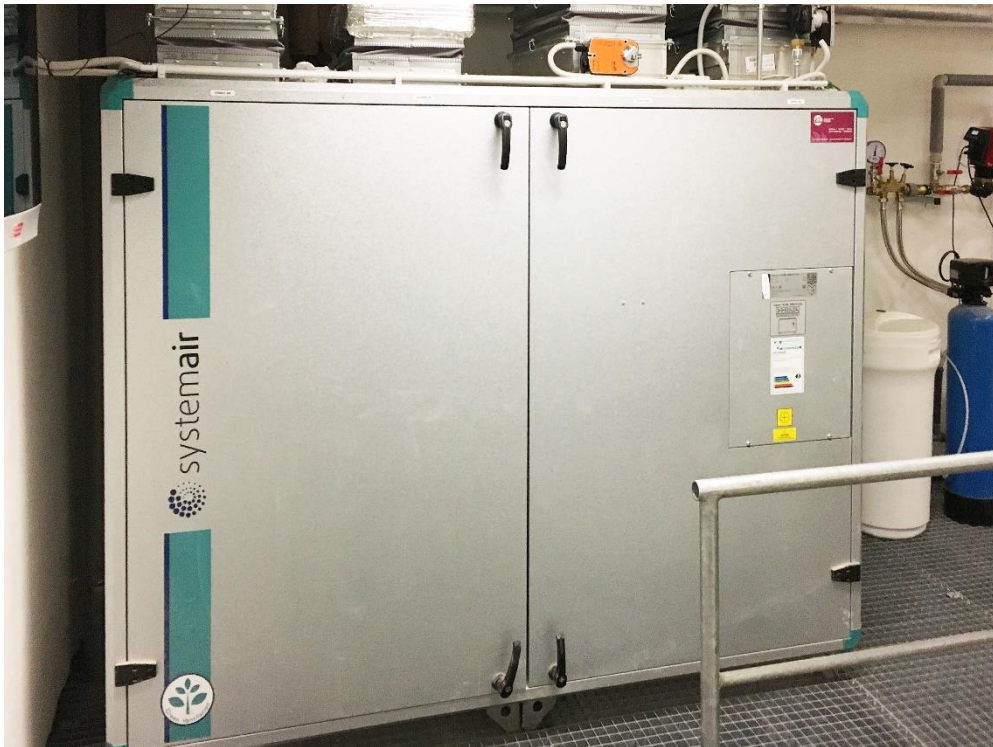
VZT s rekuperací - objekt A
